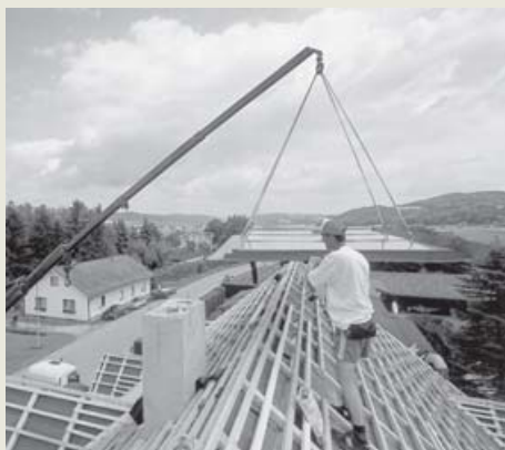
Vyzvednutí kolektoru na střechu ve vodorovné poloze
