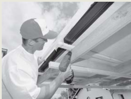
Odmontovat dřevěnou konstrukci z kolektoru
