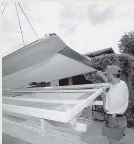
Sejmout dřevěnou konstrukci z kolektoru
