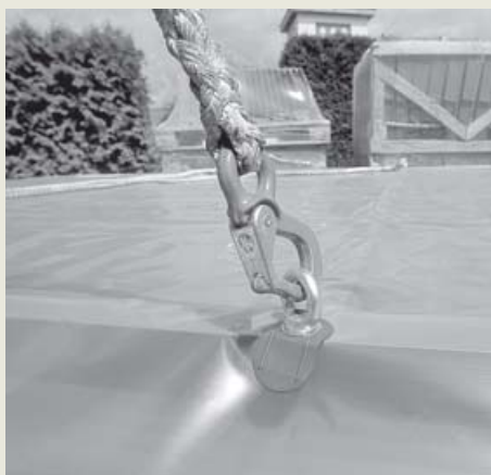
Zavěsit zvedací lano – hák na kolektor
